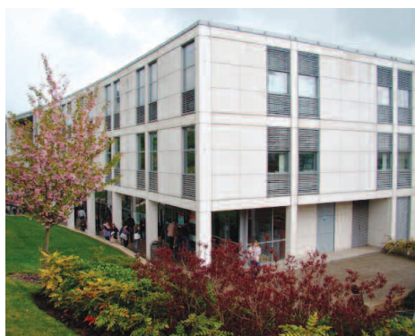
Fot. 1. Prefabrykowany budynek biurowy Photo 1. Precast office building
