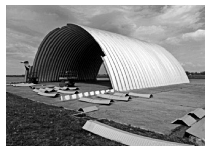
Fot. 7. Montaż dachu łukowego w systemie TG [10]
