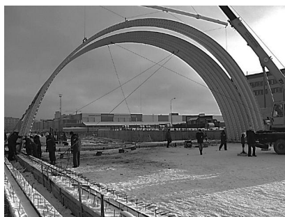
Fot. 4. Montaż przekrycia w systemie ABM 240 [6] Photo 4. Installation of the cover in ABM 240 system [6]
