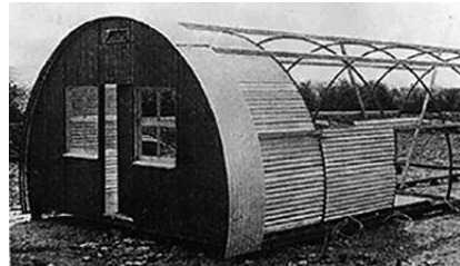
Fot. 1. System konstrukcyjny Nissen Bow Hut z czasów I wojny światowej [2] Photo 1. Nissen Bow Hut construction system from World War I [2]
