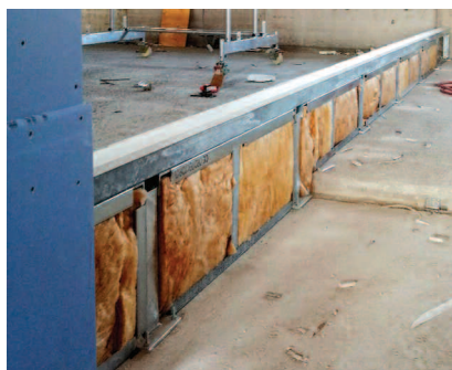
Fot. 4. Wypełnienie konstrukcji podstawy ściany płytami z wełny mineralnej
