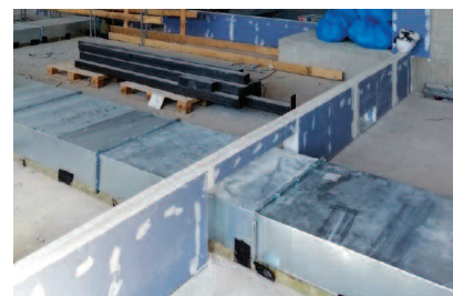
Fot. 5. Przejście instalacji wentylacyjnej przez podstawę ściany
