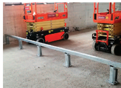
Fot. 3. Konstrukcja podstawy ściany wewnętrznej
