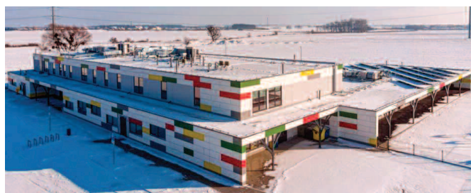
Fot. 4. Kompleks żłobkowo-przedszkolny w Kielczewie, gmina Długoleka
