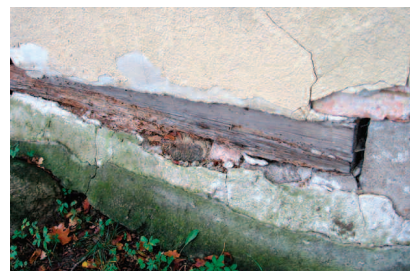
Fot. 3. Fragment elewacji północno-zachodniej kościoła w Sękowicach. Skorodowana, skompresowana belka podwalinowa. Zawilgocony cokół i fundament
