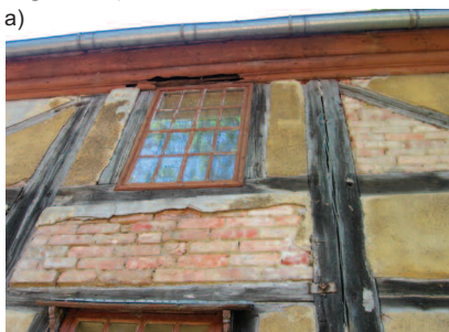
Fot. 3. Fragment elewacji północno-zachodniej kościoła w Sękowicach. Skorodowana, skompresowana belka podwalinowa. Zawilgocony cokół i fundament
