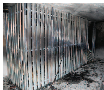
Fot. 2. Zaplecze miejsca postojowego, po pożarze garażu Photo 2. Parking space facilities, after a garage fire
