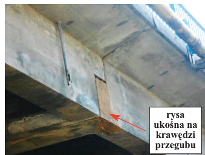
Fot. 2. Widok przegubu z zaznaczonym miejscem powstania rysy ukośnej Photo 2. Hinge side view with the crack
