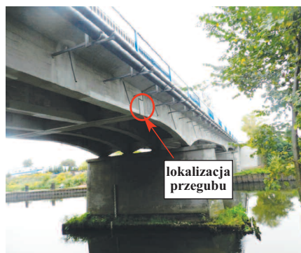
Fot. 1. Widok ogólny mostu Photo 1. General view of the bridge
