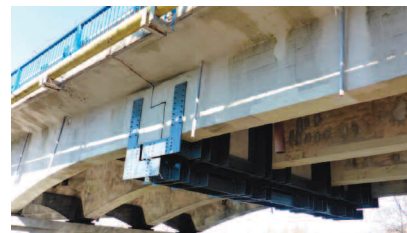
Fot. 3. Widok wzmocnionego przegubu
