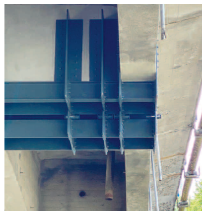
Fot. 4. Fragment wzmocnienia przegubu
