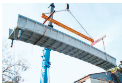
Fot. 3. Kładka ze zbrojeniem tekstylnym w Kempten-Allgau [18] Photo 3. Footbridge with textile reinforcement in Kempten-Allgau [18]
