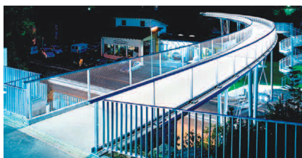
Fot. 2. Pierwsza kładka ze zbrojeniem tekstylnym w Albstadt-Lautlingen [9, 23] Photo 2. First footbridge with textile reinforcement in Albstadt-Lautlingen [9, 23]
