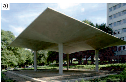
Fot. 4. Przykłady przekryć powłokowych: a) pawilon w Aachen [5]; b) pawilon w Kahla [5]; Photo 4. Examples of roofing structures: a) pavilion in Aachen [5]; b) pavilion in Kahla [5];
