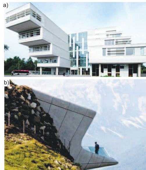
Fot. 5. Przykłady zastosowania płyt ze zbrojeniem tekstylnym: a) fasada budynku [23]; b) zakrzywiona fasada Messner Mountain Museum Coronas na górze Kronplatz we Włoszech [2]
