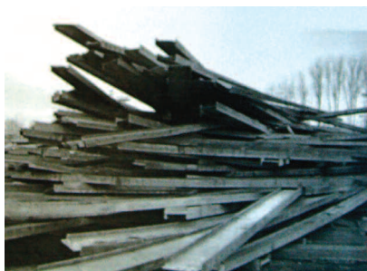
Fot. 1. Składowane na terenie rozbiórki stalowe elementy konstrukcyjne z demontażu budynku zakładów mięsnych [10]
