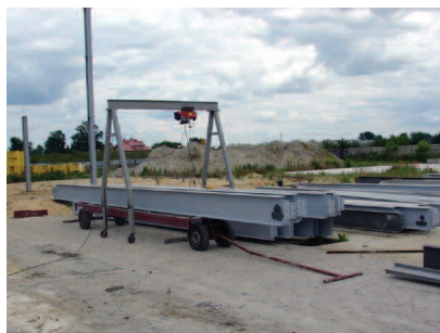
Fot. 2. Przygotowane do montażu stalowe elementy konstrukcyjne pochodzące z rozbiórki konstrukcji nośnej hali zakładów mięsnych znajdujące się na terenie budowy budynku biurowo-magazynowego
