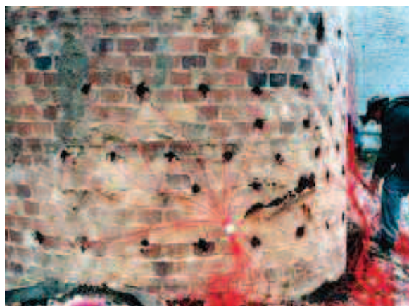
Fot. 3. Nawiercone otwory pod ładunki wybuchowe
