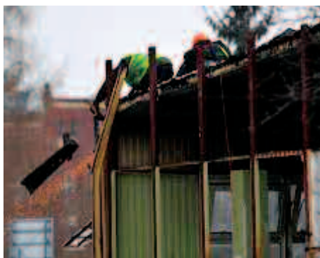
Fot. 1. Ręczne prace rozbiórkowe
