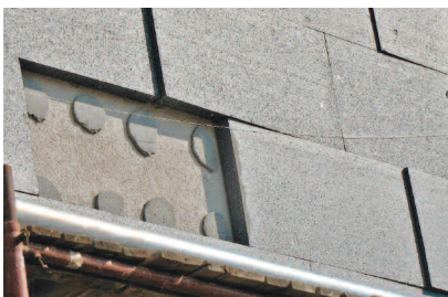
Fot. 3. Odkształcenie i odpadnięcie termoizolacji z elewacji budynku
