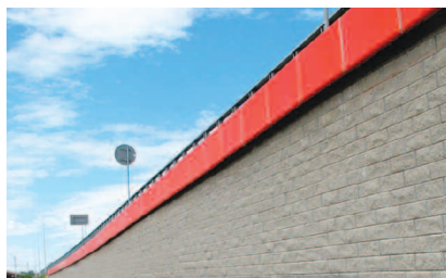
Fot. 2. Gzyms polimerobetonowy zwieńczający ścianę boczną przyczółka wiaduktu Photo 2. Polymer concrete cornice on the edge of abutment side wall
