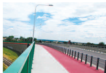
Fot. 1. Izolacionawierzchnia na bazie żywic syntetycznych – obciążenie ruchem pieszych i rowerowym
