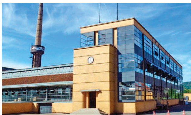
Fot. 3. Fabryka Fagus – stan obecny, całkowicie szklany narożnik pozbawiony filara Źródło: CC-BY-NC-SA @ Kulturstiftung Sachsen-Anhalt, Kunstmuseum Moritzburg Halle (Saale) Photo 3. Fagus – current state, completely glass corner without a pillar
