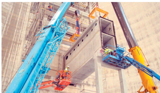
Fot. 4. Betonowe prefabrykаты przestrzenne do szybkiego łączenia na placu budowy
