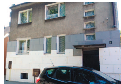
Przykładowe ocieplenie ścian metodą ETICS
