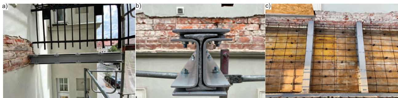
Fot. 3. Wdrożone rozwiązania wzmacniające uszkodzoną konstrukcję balkonu: a) widok boczny wzmocnienia; b) widok czola wspornika; c) widok z góry (widoczna ścianka zbrojeniowa płyty balkon) Fot. M. Gasz Photo 3. Implemented solutions to strengthening the damaged structure of the balcony: a) side view of the strengthening; b) face view of the cantilever; c) top view (visible reinforcement mesh of the balcony slab)
