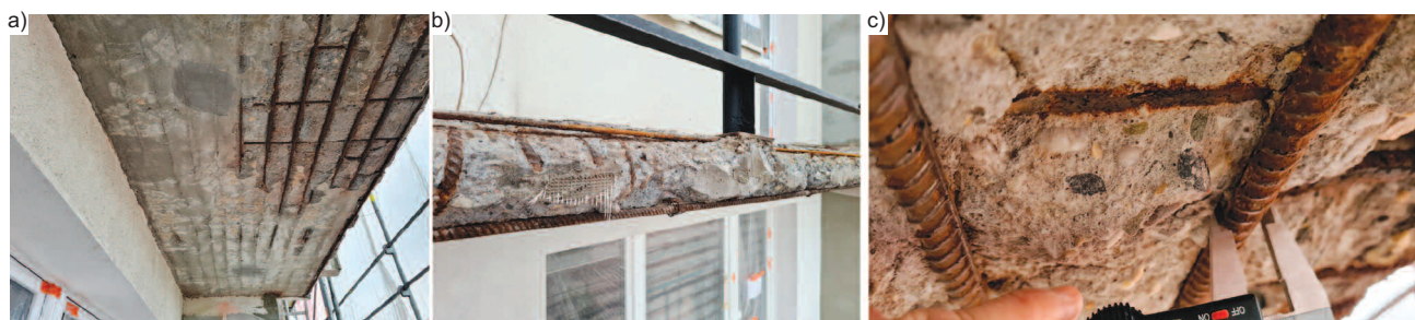
Fot. 4. Rodzaj i zakres uszkodzeń żelbetowych płyt loggii: a) brak dolnej otuliny oraz ubytki betonu po jego rozwarstwieniu i odspojeniu się; b) ubytki betonu w licach płyt; c) ubytki betonu na spodniej części płyt i pomiar średnicy wkładek zbrojeniowych Fot. Autor Photo 4. Type and the scope of damages to the reinforced concrete slabs of the loggias: a) lack of lower concrete bar cover and losses of concrete after its delamination and detachment; b) losses of concrete in the faces of the slabs; c) losses of concrete on the underside of the slabs and measurements of diameters of the reinforcement bars
