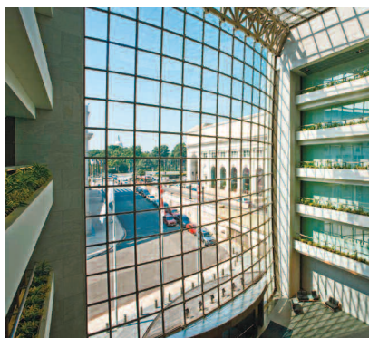
Fot. 6. Dwukrzywiznowa siatka cięgnowa w budynku Komisji Papierów Wartościowych i Giełd w Waszyngtonie Photo. 6. Double-curved cable-net in the Security & Exchange Commission Headquarters in Washington
