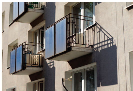
Fot. 4. Mała powierzchnia balkonów Photo 4. Small area of balconies
