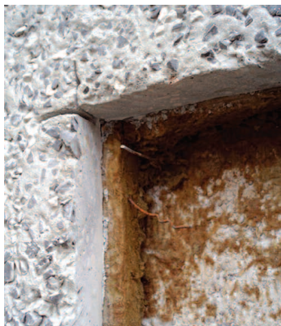
Fot. 2. Miejsce pobrania próbki z warstwy elewacyjnej ściany zewnętrznej budynku wysokiego
