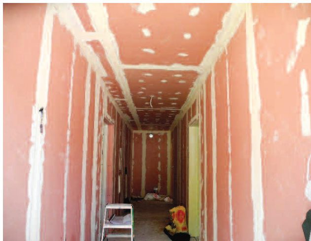
Fot 2. Widok od wewnątrz budynku o konstrukcji drewnianej przeznaczonego do badań poligonowych w pełnej skali Photo 2. Interior view of a wooden structure building intended for full-scale fire tests
