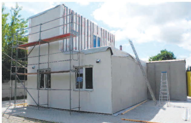
Fot. 1. Montaż budynku o konstrukcji drewnianej przeznaczonego do badań poligonowych w pełnej skali Photo 1. Exterior view of a wooden structure building intended for full-scale fire tests, assembly
