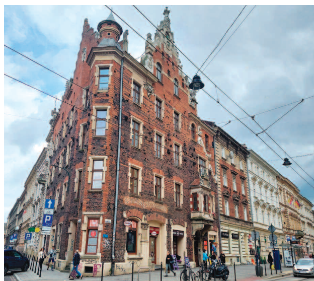
Fot. 2. Kamienica „Pod Pajakiem”, na której Teodor Talowski zaprojektował jedną z pierwszych zielonych elewacji w Krakowie, obecnie na pierwszym planie „kamienna pustynia” Photo 2. „Stone desert” – in the foreground the „Pod Pajakiem” tenement house, on which Teodor Talowski designed one of the first green facades in Cracow
