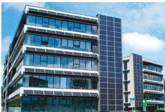
Fot. 5. Elewacja z ogniwami fotowoltaicznymi – Katowice Photo 5. Facade with photovoltaic cells – Katowice
