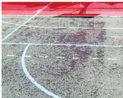
Fot. 2. Zużycie warstwy wierzchniej nawierzchni syntetycznej
