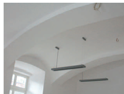
Fot. 3. Sklepienie nad parterem w Pałacu Królewskim w Łobzowie (Kraków) po remoncie i wzmocnieniu siatką kompozytową Photo 3. Vault over the ground floor of the Royal Palace in Łobzów (Cracow) after renovation and reinforcement with composite mesh
