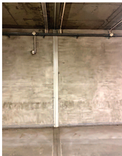
Fot. 3. Dylatacja konstrukcyjna dzieląca strop i ścianę nośną w garażu podziemnym Photo 3. Structural expansion joint dividing the floor and the load-bearing wall in the underground garage
