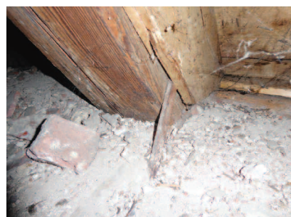
Fot. 4. Jednostronny brak klamry łączącej krokiew z belką więzarową Photo 4. Iron brace absence between rafter and truss beam
