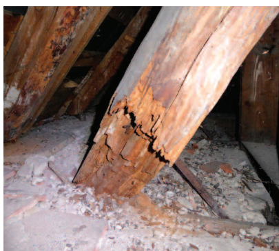
Fot. 1. Dolny odcinek krokwi uszkodzony wskutek korozji biologicznej Photo 1. Damaged bottom rafter section infected with biological corrosion
