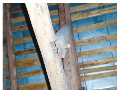
Fot. 3. Rozluźnione połączenie jętki z zastrzałem Photo 3. Loose strut-collar beam joint
