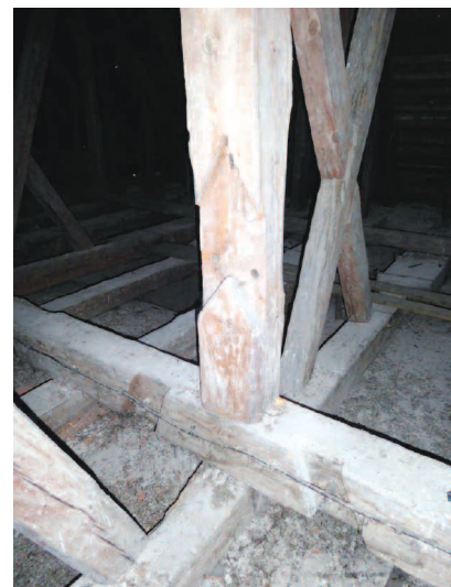
Fot. 2. Brak dwóch zastrzałów, bez których storczyk nie jest połączony z podwaliną i belką więzarową Photo 2. Lack of two struts, without which suspended column and truss beam is not connected
