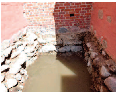
Fot. 1. Odkrytka uwidaczniająca potrzebę wykonania drenażu odwadniająco-osuszającego (kościół św. Andrzeja Apostoła w Barczewie)
