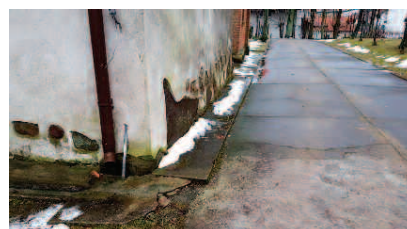
Fot. 2. Uszczelniony powierzchniowo teren wokół zabytkowej budowli
