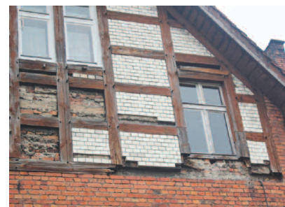
Fot. 3. Typowe uszkodzenia elementów li-cowych z płytek szklonych i elementów drewnianych muru pruskiego oraz ubytki muru Fot. T. Steidl Photo 3. Typical damage to facing elements made of glazed tiles and timber elements of the half-timbered wall as well as wall defects
