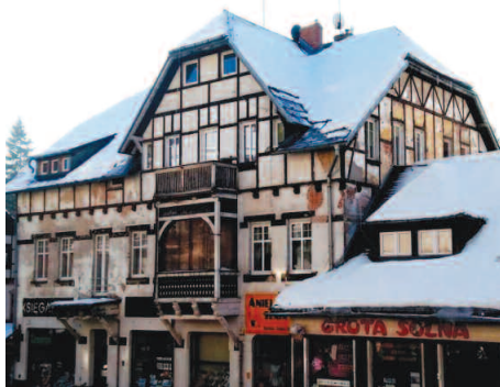
Fot. 1. Odremontowany budynek mieszkalny wykonany w technologii szkieletowej (szachulec) Fot. A. Gwiżdż Photo 1. A residential building made in framework technology (half-timbered house)
