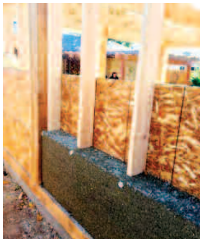
Fot. 1. Metoda szalunkowa budowy przegrody zewnętrznej z kompozytu konopno-wapiennego [9]
