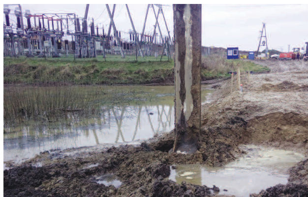
Fot. 2. Realizacja wzmocnienia podłoża na obwodnicy Szczecinka Photo 2. Realization of ground strengthening in ring road for Szczecinek
