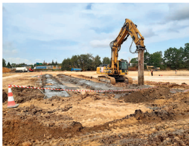
Fot. 3. Realizacja solidyfikacji na mokro w Żorach Photo 3. Wet solidification in Żory
