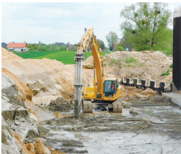
Fot. 1. Realizacja wzmocnienia podłoża za obiektem inżynierskim w ciągu drogi S5
