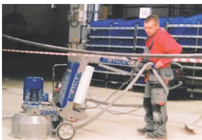
Fot. 3. Szlifowanie podkładu betonowego pod posadzkę epoksydową
