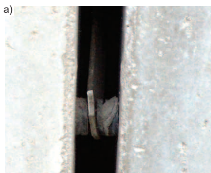
Fot. 2. Nieodpowiednio zaprojektowane kotwy: a) skręcenie kotwy; b) wygięcie płaskownika i sworznia kotwy Photo 2. Improperly designed anchors: a) twist of the anchor; b) bend of the flat bar and anchor bolt
