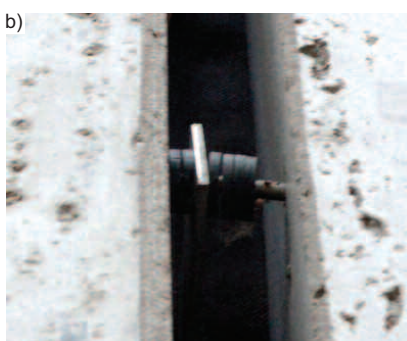
Fot. 2. Nieodpowiednio zaprojektowane kotwy: a) skręcenie kotwy; b) wygięcie płaskownika i sworznia kotwy Photo 2. Improperly designed anchors: a) twist of the anchor; b) bend of the flat bar and anchor bolt
