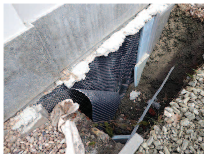
Fot. 1. Zabezpieczenie powierzchni zewnętrznej ściany piwnicznej w fosie przyściennej
