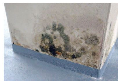
Fot. 3. Rozwój grzybów pleśniowych na zawilgoconych ścianach piwnic
