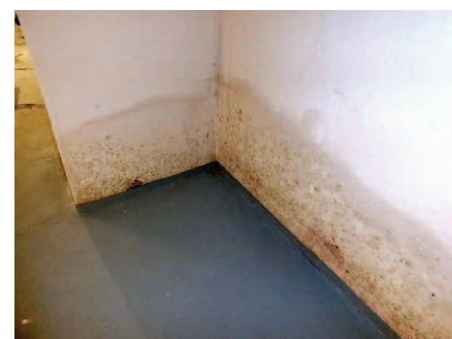
Fot. 2. Nadmierne zawilgocenie dolnych odcinków ścian piwnic
