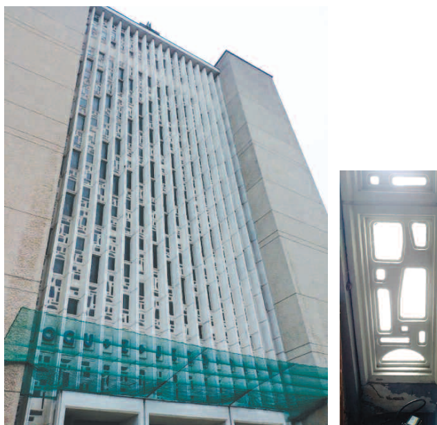
Fot. 2. Elementy prefabrykowane na elewacji frontowej kościoła Photo 2. Prefabricated elements of the church on the front elevation
