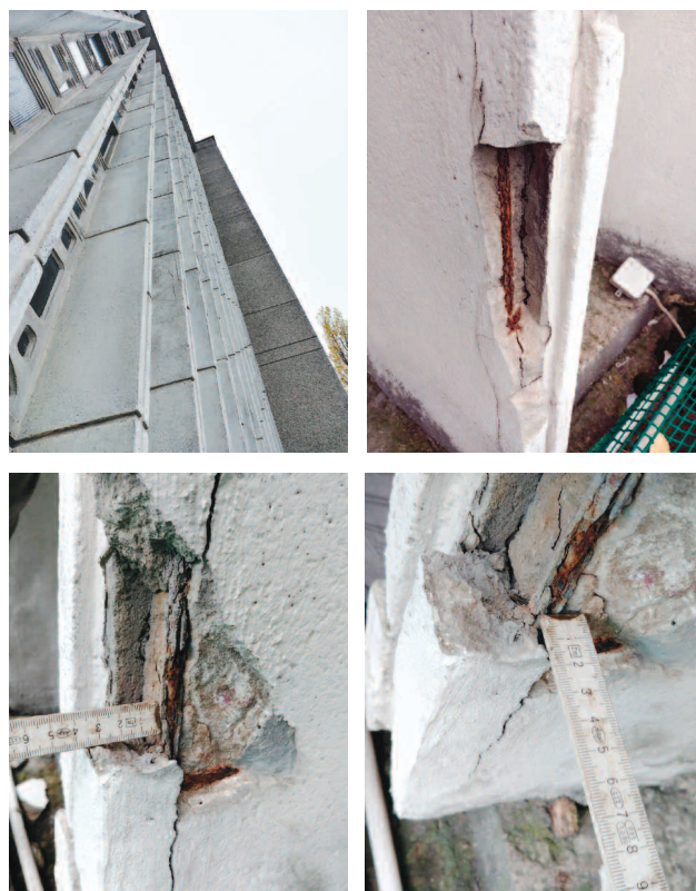
Fot. 4. Rozległe uszkodzenia elementów elewacyjnych Photo 4. Extensive damage to facade elements
