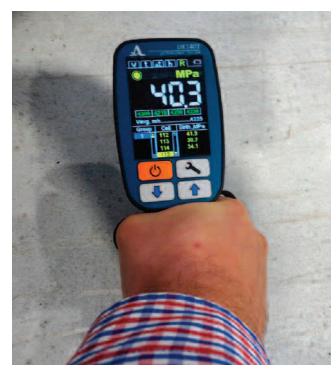
Fot. 2. Ultradźwiękowy pomiar wytrzymałości betonu posadzki
