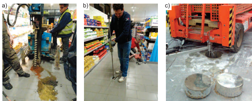
Fot. 1. Badania podłoża i podbudowy pod posadzką: a) odwiert geotechniczny; b) badanie lekką sondą dynamiczną; c) badanie płytą VSS
