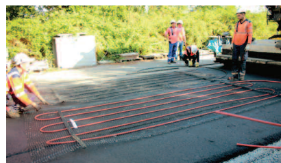
Fot. 1. Układanie przewodów grzewczych Photo 1. Pipe assembly
