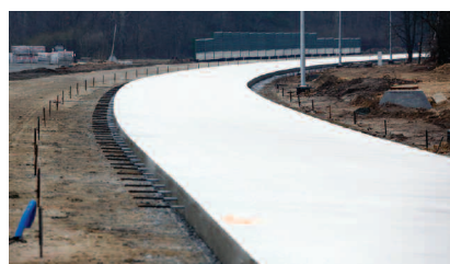
Fot. 2. Nawierzchnia drogi DW 423 po ułożeniu Photo 2. Surface of road DW 423 after casting
