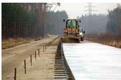
Fot. 3. Szczotkowanie górnej warstwy nawierzchni drogi DW 423 Photo 3. Upper surface brushing of road DW 423
