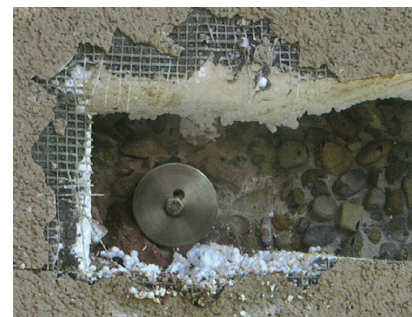
Fot. 2. Widok osadzonej w ścianie trójwarstwowej kotwy stalowej [5]
