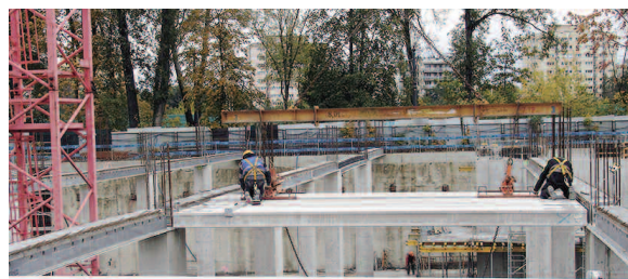
Montaż stropu typu slim floor z płyt kanałowych opartych na belkach BH
