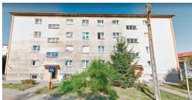
Fot. 2. Stan istniejącego bloku mieszkalnego czterokondygnacyjnego
