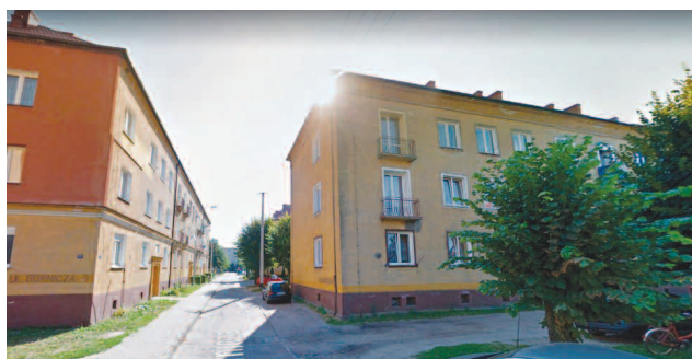
Fot. 1. Stan istniejącego bloku mieszkalnego trzykondygnacyjnego
