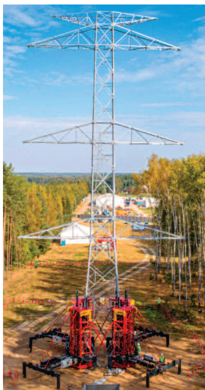
Fot. 2. System podnośników przy słupie podczas testów
