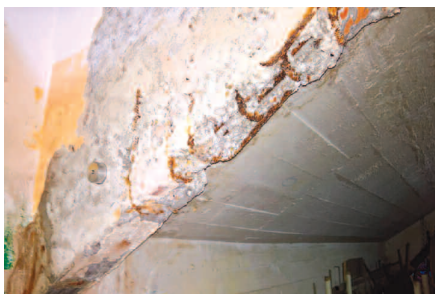
Fot. 1. Badanie wytrzymałości betonu na odrywanie metodą pull-off Photo 1. Pull-off concrete strength test
