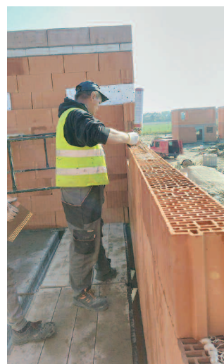
Fot. 1. Mur z pustaków ceramicznych. Widoczne paski kleju w spoinie poziomej niższej warstwy pustaków – brak widocznych śladów rozplywania się kleju po powierzchni wspornej pod ułożoną warstwą
