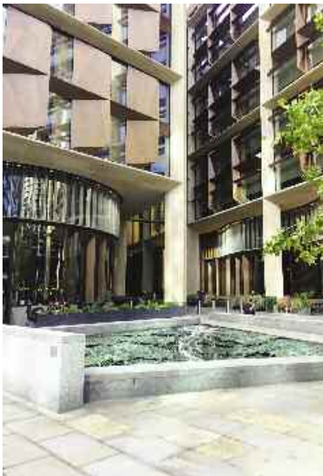
Fot. 2. Elewacja z osłonami przeciwsłonecznymi, które równocześnie pełnią funkcje przewietrzania i pochłaniania hałasu Photo 2. Elevation with sunshades, which simultaneously perform the functions of ventilation and noise absorption
