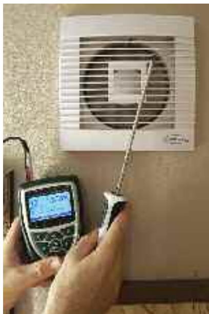
Kontrola prędkości powietrza na kratce wentylacji naturalnej termooanemometrem cyfrowym firmy Ahlborn
